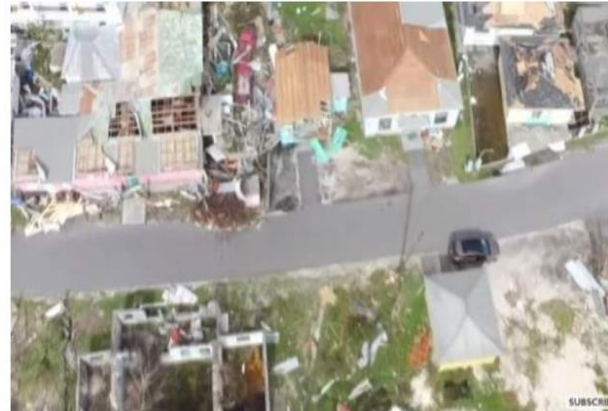
Imagen de la destrucción causada por el huracán Irma en la isla de Barbuda. / YOUTUBE
