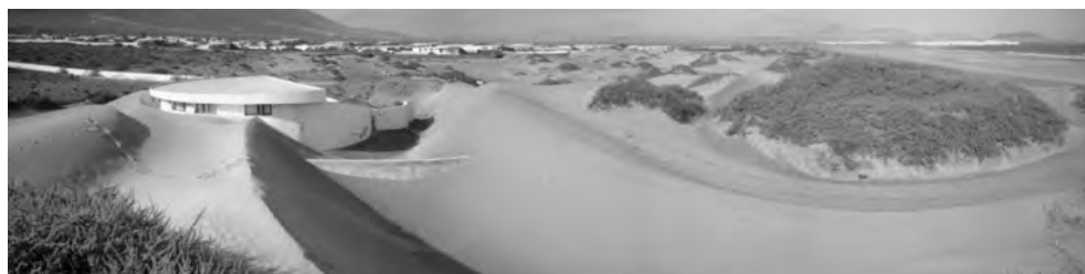
Figura 3. Acumulación de sedimento en la zona baja de la urbanización Island Homes
