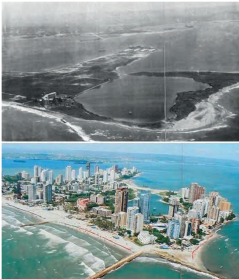
Figura 2. Ejemplo de la construcción de obras de defensa en la ciudad de Cartagena
