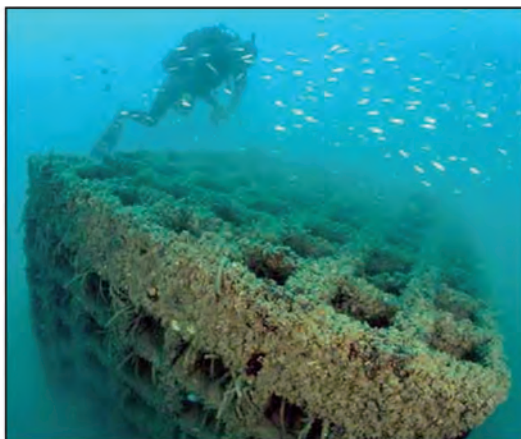
Figura 5. Estado actual de las estructuras mixtas del PEBCN
