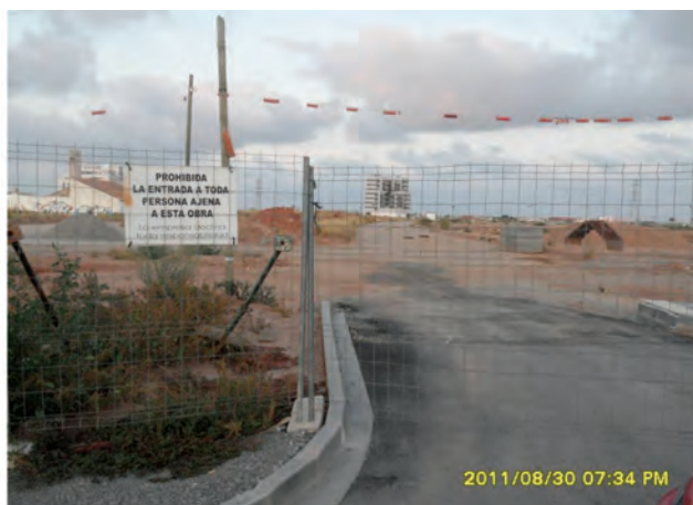
En proceso de transformación abandonado
