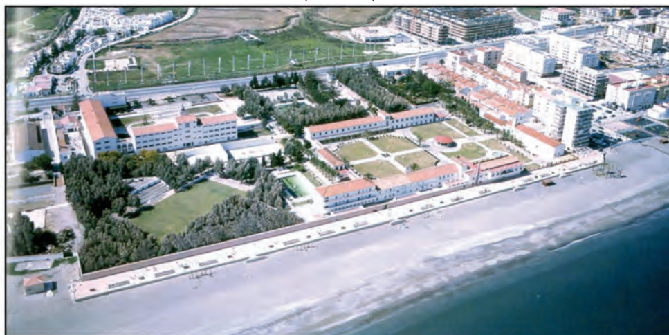
Figura 2. Paseo marítimo construido sobre la misma playa. Sabinillas-La Colonia (Manilva)
