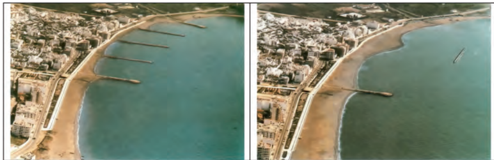
Figura 3. Acondicionamiento de la playa de Estepona (A la izquierda: estado inicial; a la derecha: estado final)
