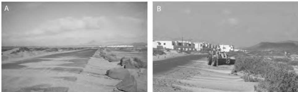
Figura 4. (A) Rocas en el margen norte de la carretera que une la urbanización Famara con Caleta de Famara y duna tractor en el margen sur. B) Maniobra de extracción del sedimento al norte de dicha carretera
